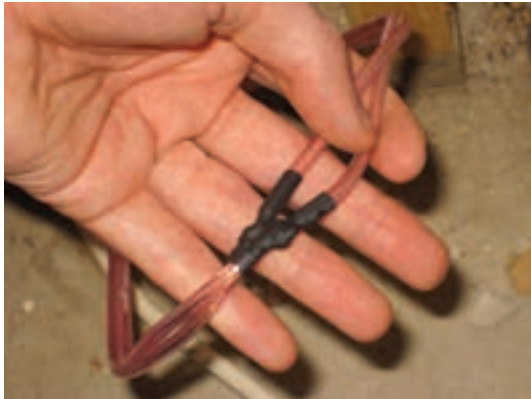
شکل ۱-۶۴- اتصال لحیم‌کاری شده سه‌تایی با عایق حرارتی
