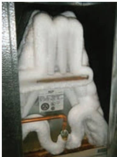
شکل ۶-۱۰- تشکیل برفک بر روی اواپراتور
