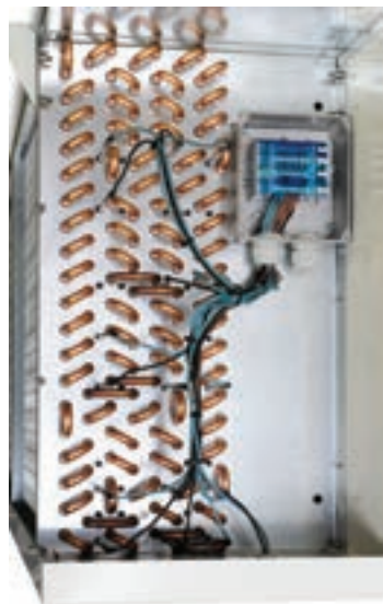
شکل ۶-۱۱- محل نصب هیترهای مورد نیاز
