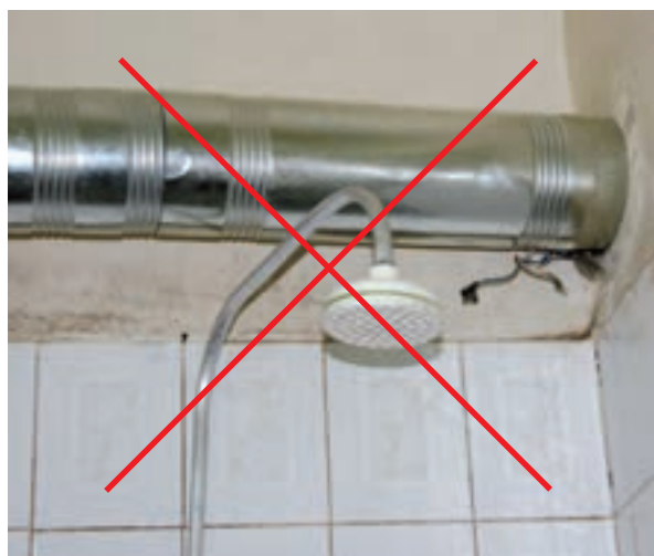
شکل ۳-۱۱ عبور غیر مجاز دودکش
