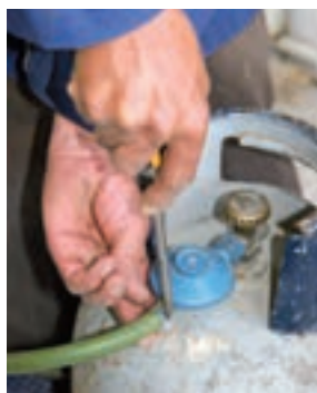
شکل ۱-۶۶ ب سفت کردن بست
