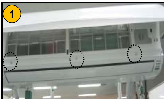
1 صفحه ورودی هوا را بلند کرده و 3 پیچ را باز کنید.
