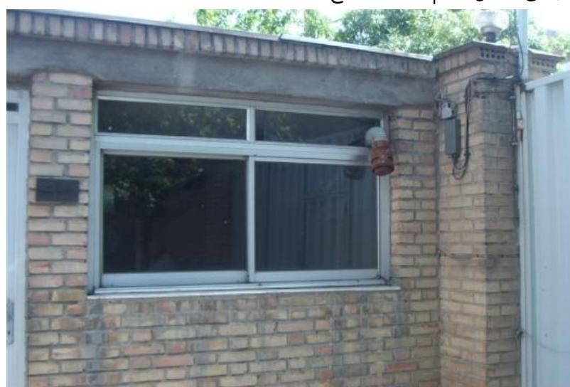
استفاده از لوله های انعطاف پذیر و نحوه نصب نامناسب آن
