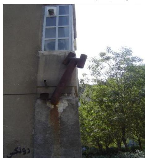
استفاده از کلاهک های انتهائی غیر استاندارد و عدم رعایت فاصله افقی ۱ متر از دیوار
