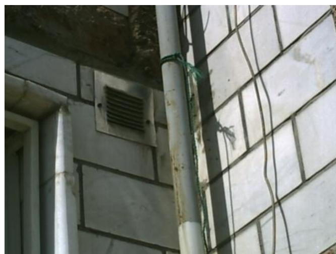
پیچش کلاهک انتهائی بدلیل عدم اتصال صحیح قطعات
