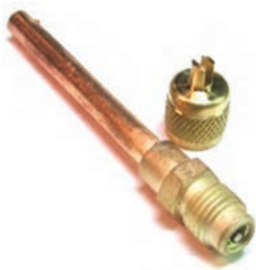
شکل ۴-۲- شیر شریدر بر روی لوله
